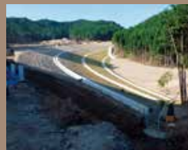
道路改良工事 (ICT 活用工事) 【但馬空港線】
