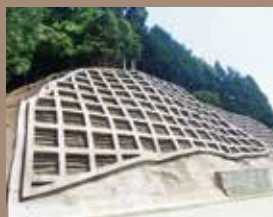
法面工事 (ICT 活用工事) 【香美久美浜線】
