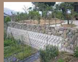
石積・造園工事
