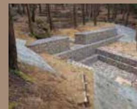
森林整備・治山工事
